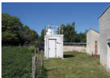
Station rurale nationale Verneuil
